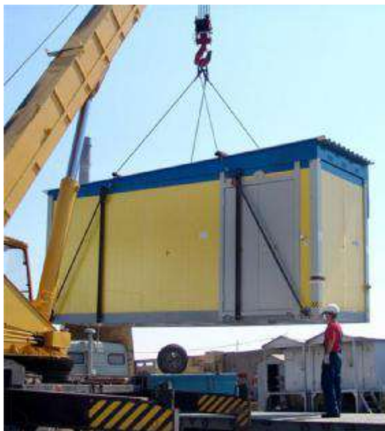
Рисунок 22. Погрузочно-разгрузочные работы КРУ-БМ
