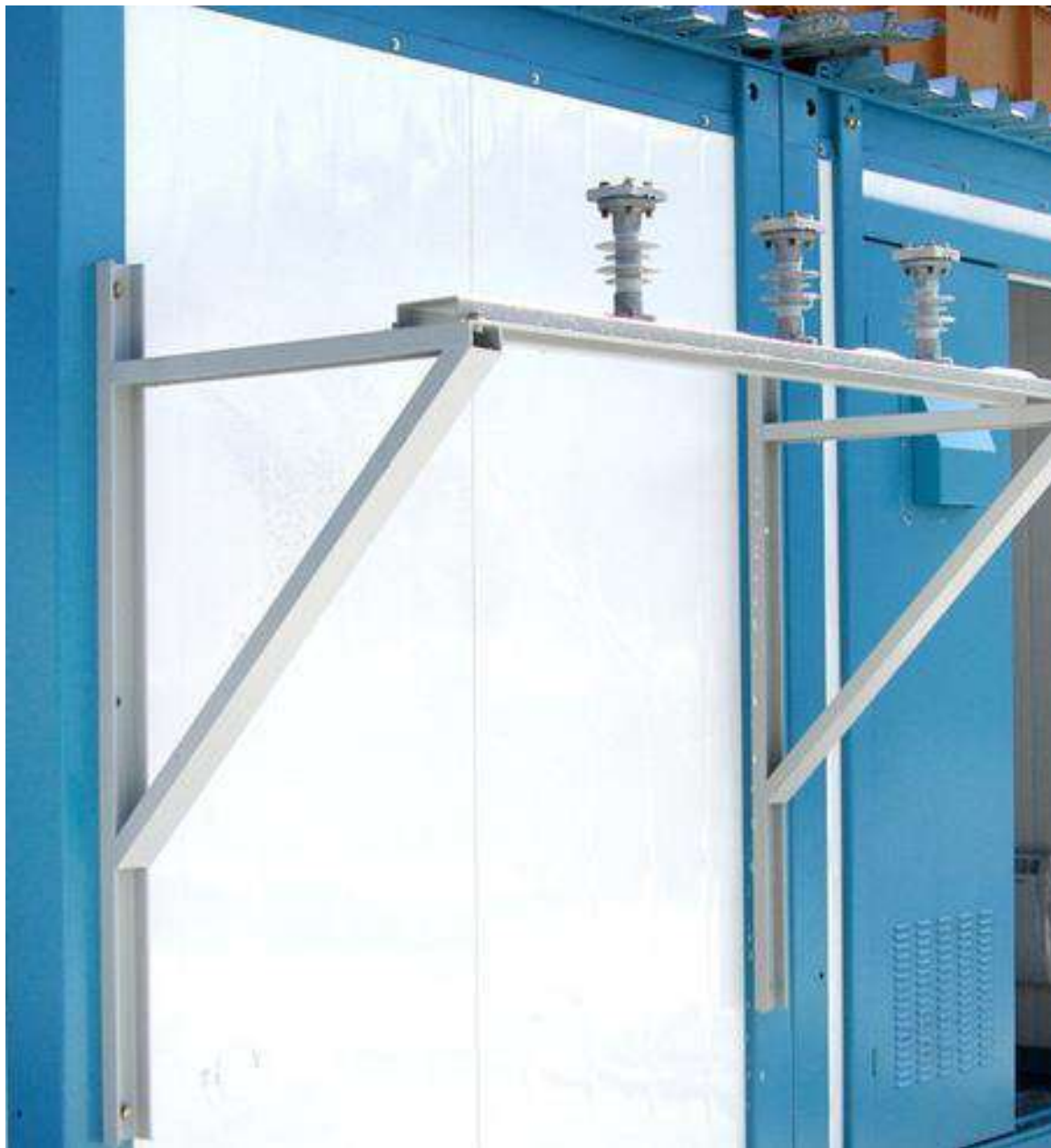
Рисунок 5. Траверса для штыревых изоляторов
