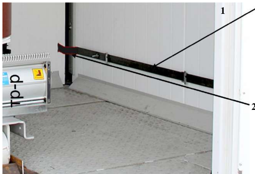
Рисунок 15. Внутренний контур заземления в БМЗ (пример)
