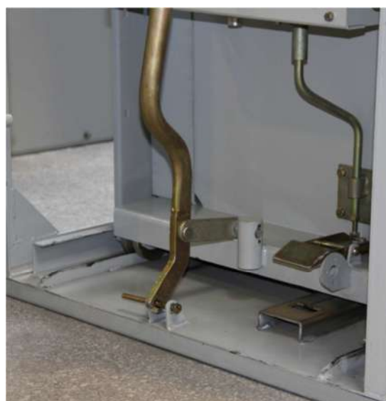
Рисунок 5 Рабочее положение тележки
